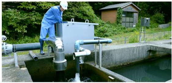
日々行う取水口の点検
