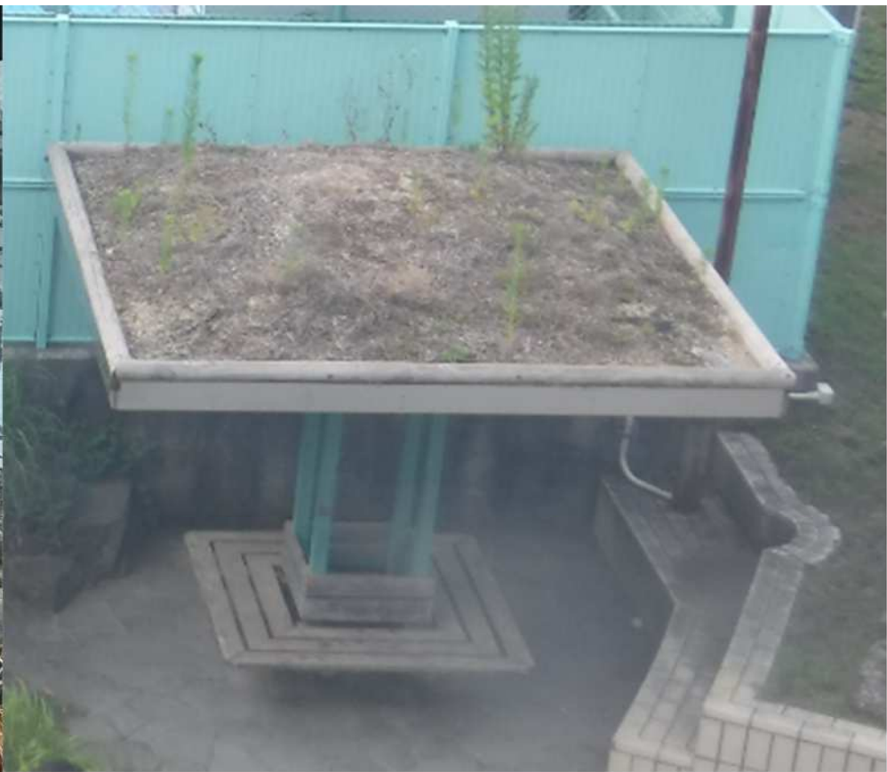
修理した東屋の屋根
