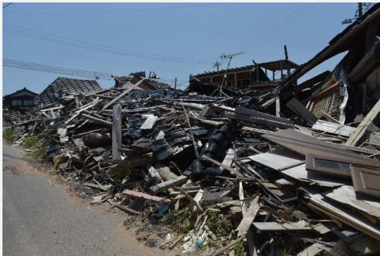
倒壊したままの家屋
